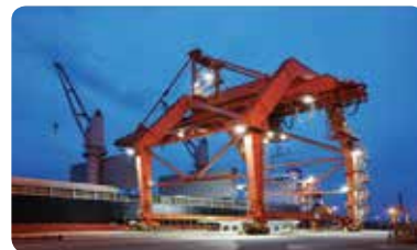
항만, 부두, 교량, 타워 등
